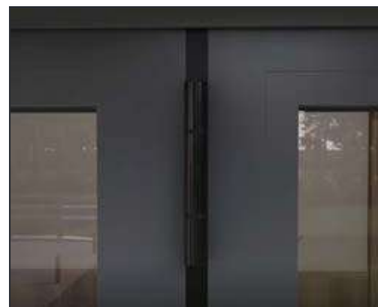
Paumelles fines alignées au joint plat
