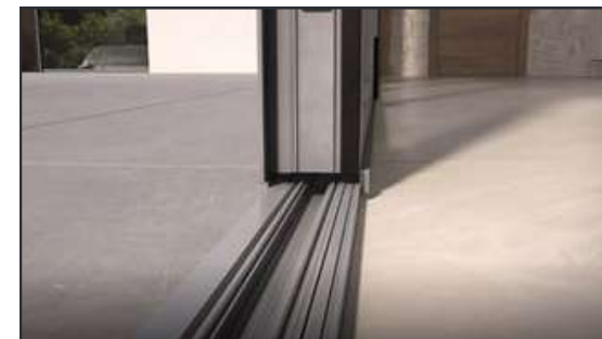
Seuil PMR à rupture de pont thermique
